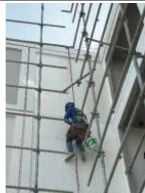
รูปที่ 21 คนงานสวมใส่อุปกรณ์ป้องกันอันตรายส่วนบุคคล
